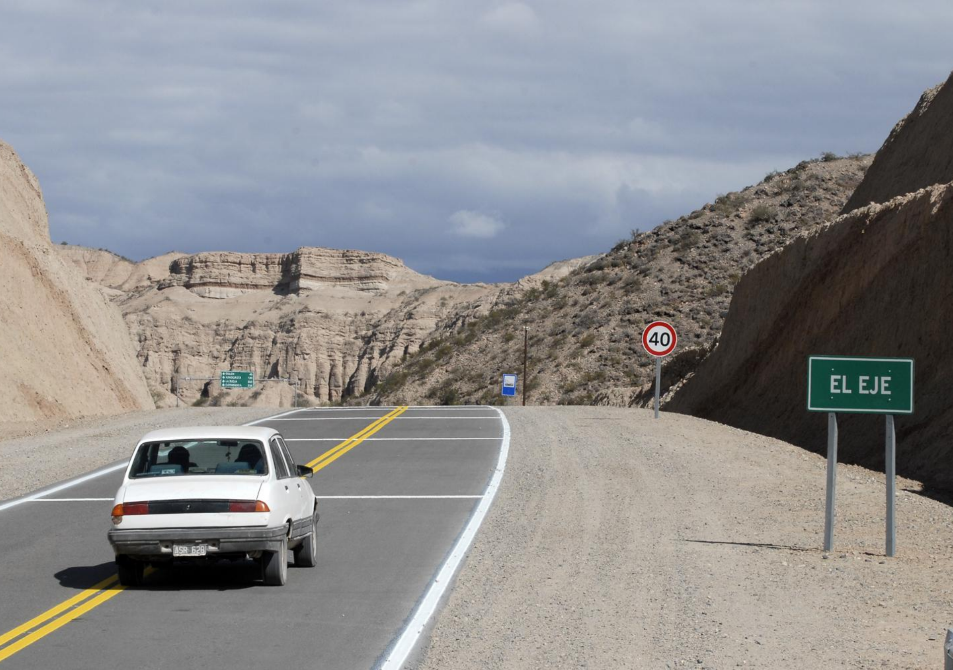
LOCALIDAD DE EL EJE, BELÉN
